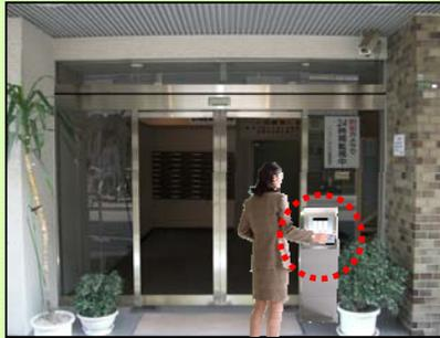
●カードリーダーへICカードをタッチするだけで、ドアが解錠されます。
