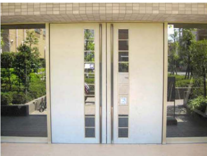
【施工前：両開き扉】
