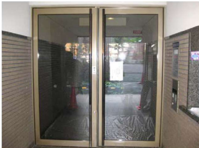
【施工前：両開き扉】
